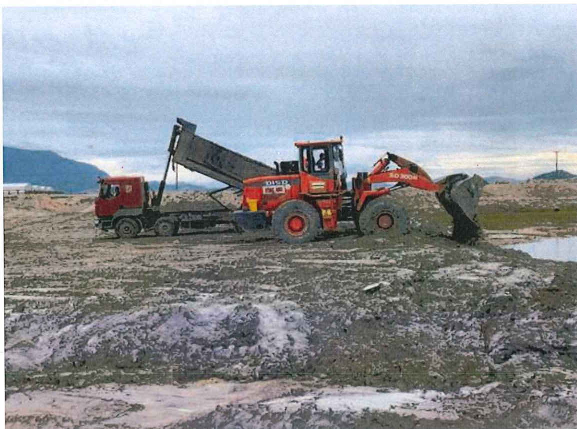
Hình 1.23. Minh họa quá trình đổ chất nạo vét và san gạt tại bãi chứa
