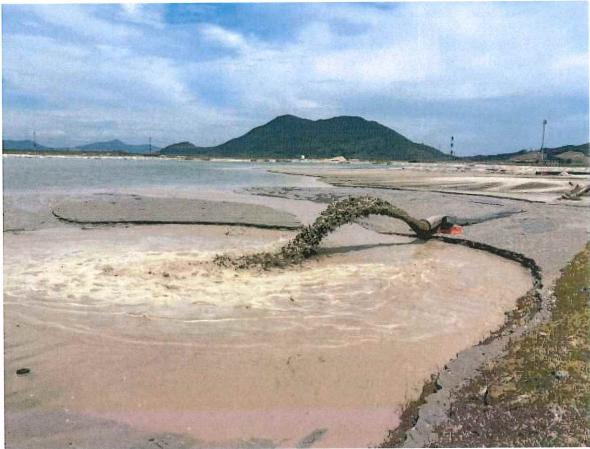
Hình 1.18. Bơm chất nạo vét lên bãi chứa (ảnh thực tế)
