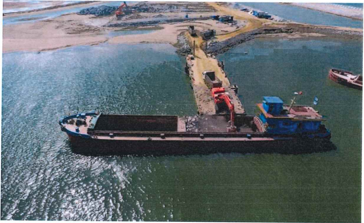
Hình 1.21. Minh họa trạm trung chuyển chất nạo vét (ảnh tham khảo)
