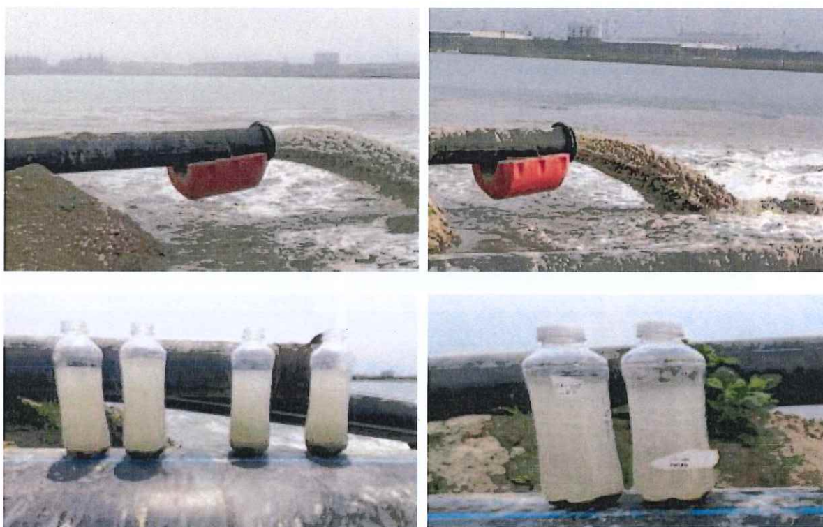
Hình 1.6. Hàm lượng chất nạo vét trong hỗn hợp bơm lên bãi chứa chỉ đạt dưới 5% nên hiệu quả công việc rất thấp (mẫu nước lấy từ đường ống bơm vào bãi chứa)
